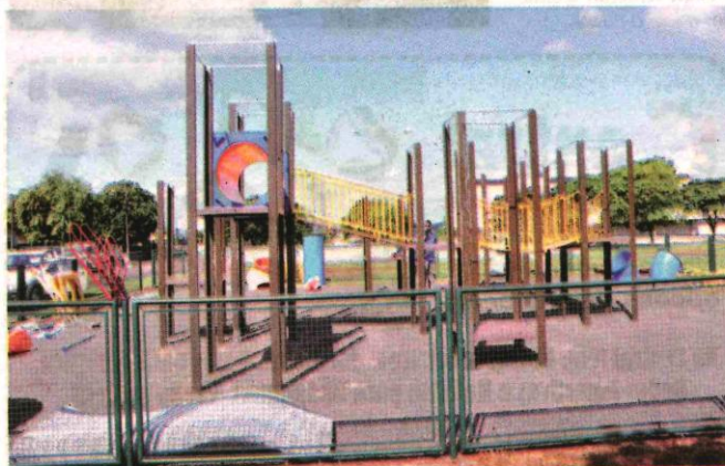
Playground infantil do Complexo Esportivo Hugo Puhl em fase final de construção.
