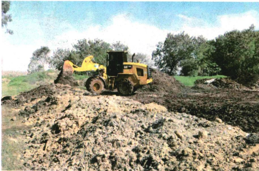
Construção de novas leiras no Centro de Compostagem
